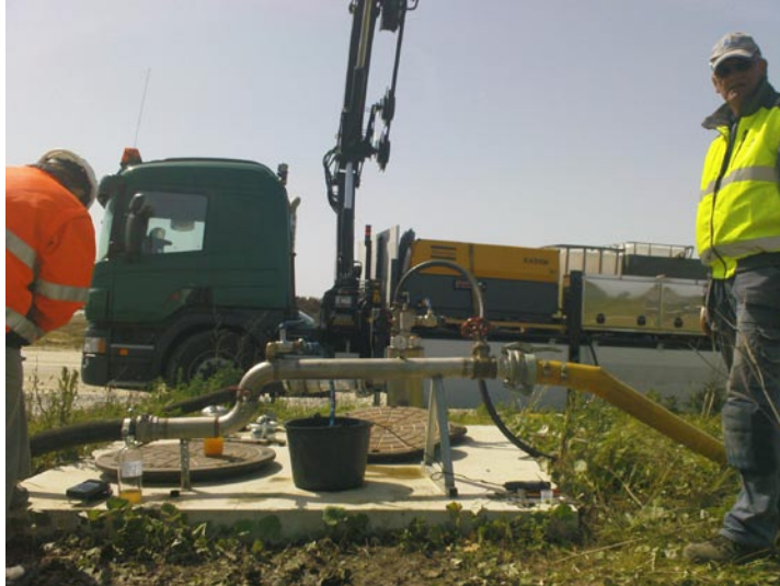
Rensning och syring av infiltrations brunn Citytunneln Malmö
